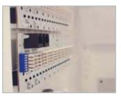
Fornecidas com botão de teste que permite certificar a Categoria 6. Ligações efectuadas no interior da caixa através da fixação dos pares com o alicate de Krone.
